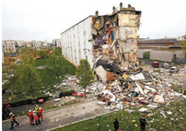
La façade éventrée de l'immeuble après l'explosion de gaz dans le quartier Wilson à Reims le 28 avril 2013.
